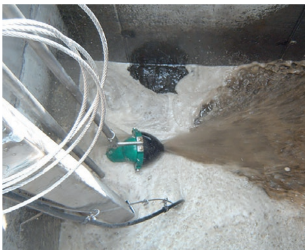
Rührdüse in Betrieb | Agitating nozzle in operation
