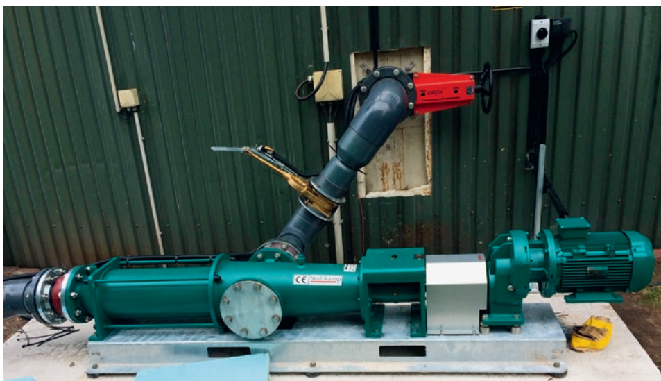
Horizontalexzenter-Schneckenpumpe im Einsatz bei einer Biogasanlage Eccentric screw pump in use in a biogas plant
