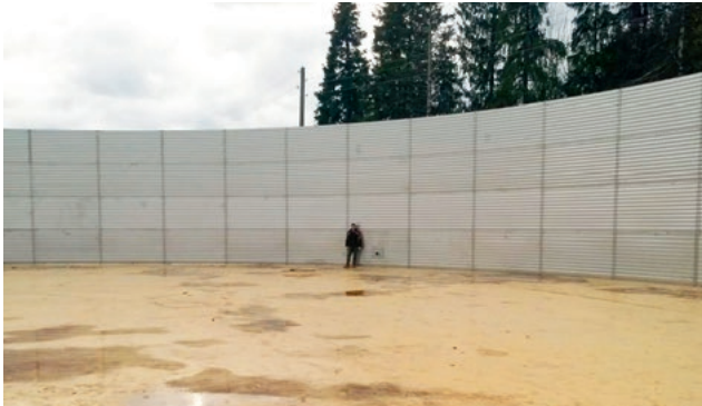
8.559 m 3 Weltgrößter Wellstahlbehälter aus Edelstahl bei Kirov (Russland) 8,559 m 3 The world's largest corrugated steel tank made of stainless steel
