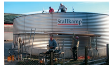
Aufgestockter Betonbehälter Heightened concrete tanks
