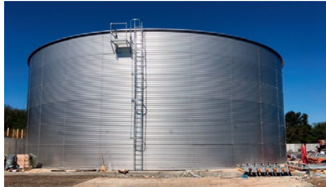
4.230 m 3 Einer von 17 Güllebehältern in Bulgarien 4,230 m 3 One out of 17 manure tanks in Bulgaria
