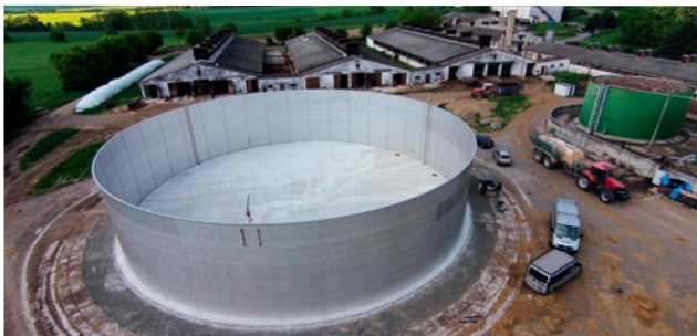
Edelstahlbehälter aus der Vogelperspektive Stainless steel tank from a bird's eye view
