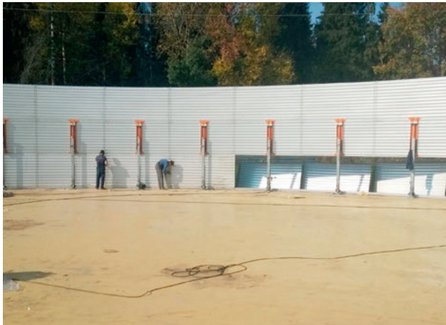
Montage mit Hebevorrichtung Assembly with lifting gear
