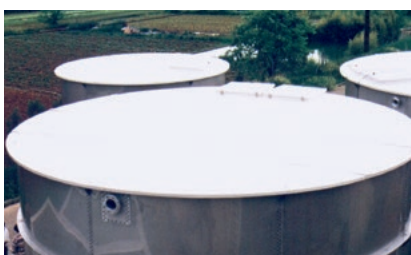
Ausführung Flachdach Flat roof design
