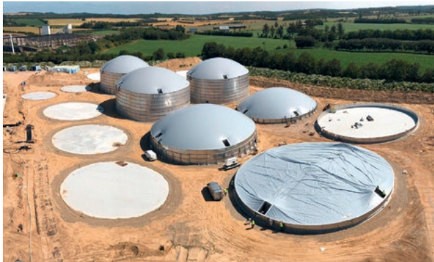
Biogasprojekt mit 14 Fermentern Biogas project with 14 digesters
