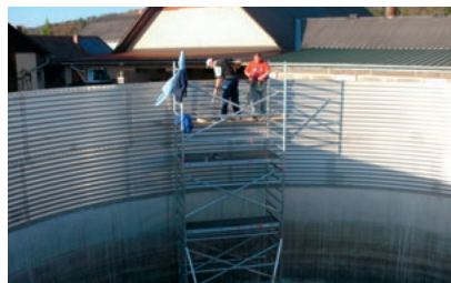
2. Ring auf Betonbehälter 2. Ring on concrete tank
