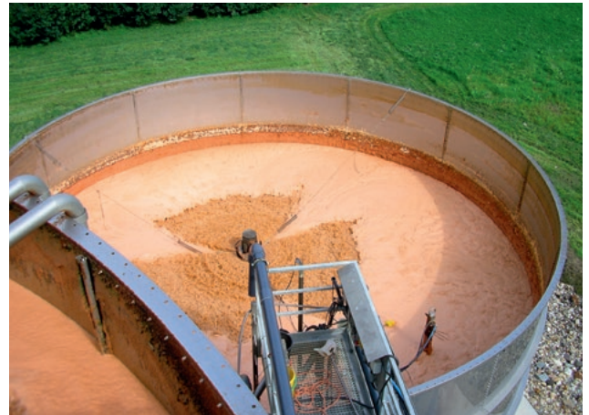
Abwasserbehälter Waste water tank
