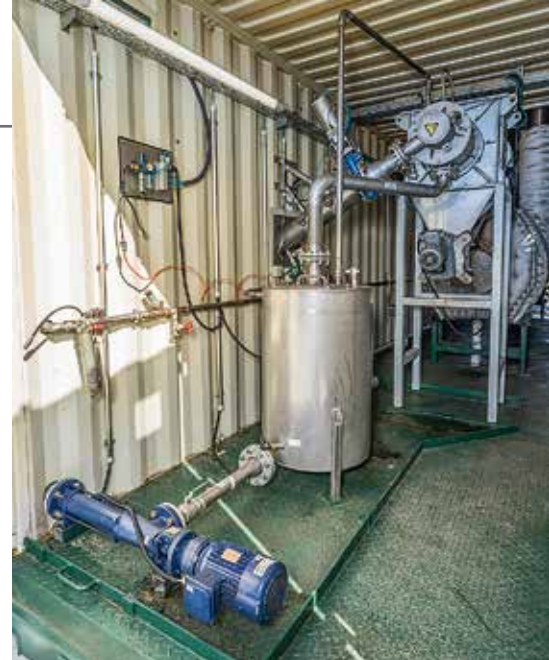
Ein Puffertank sammelt die Dünngülle aus der Separation, die Pumpe fördert sie zurück ins Endlager.
