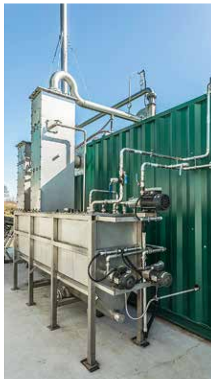
Der Abluftwäscher spült ohne Zugabe von Säure das Ammoniak aus dem Dampf.
