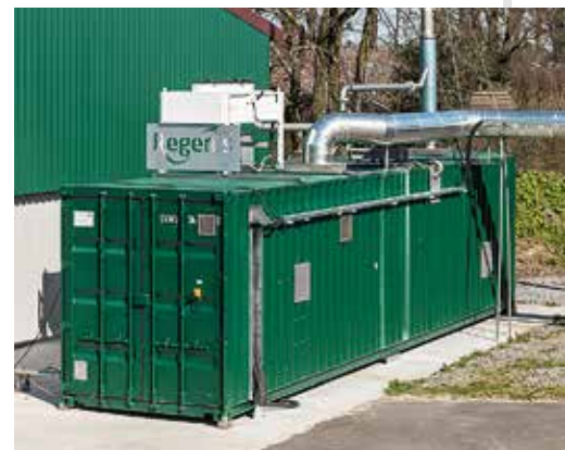
Der Separator und der Gärresttrockner sind in einem 40-Fuß-Container untergebracht.
